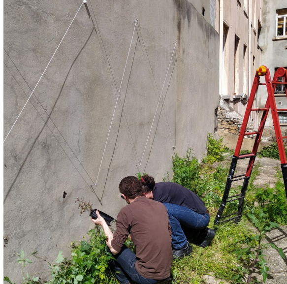
Au moment des travaux
